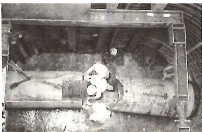
下水道管布設工事
