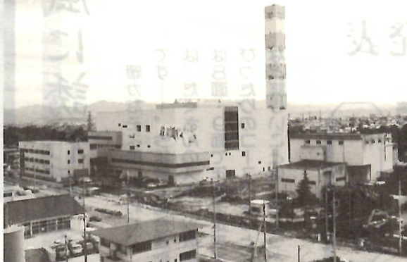
焼却能力一日405tの六供清掃工場が稼動(10月)
