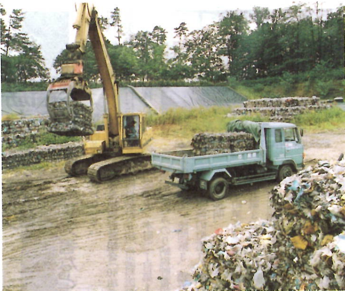
ブロック状に圧縮したゴミを埋め立てます——荻窪最終処分場
