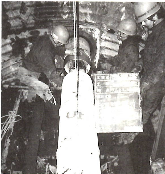
下水道工事は清潔で快適な生活実現のため
