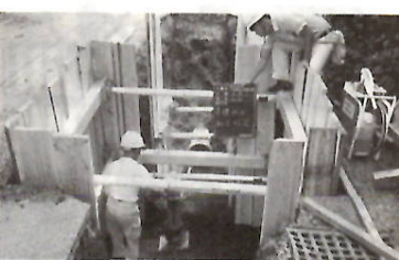
ヒューム管の布設作業
