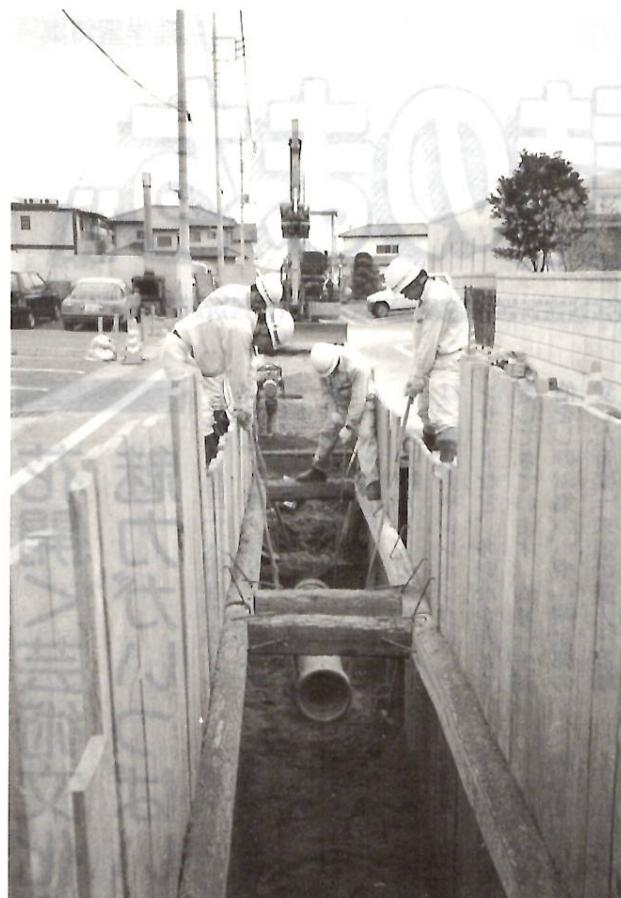
着々と進む下水道工事——荒牧町での下水管布設
