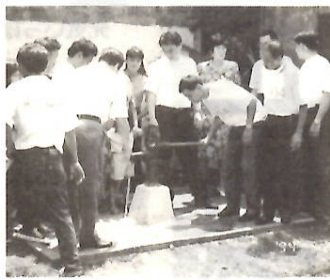
完成した第1号井戸の通水式
