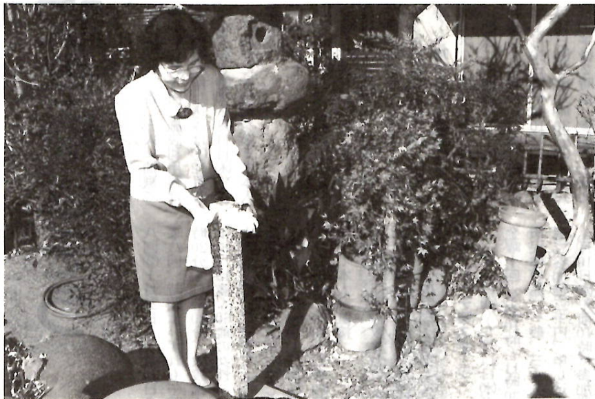
屋外の蛇口や水道管にタオルなどを巻き付けて凍結事故を防ぎましょう
