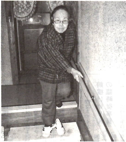
玄関に手すりを取り付け上り下りも安全に
