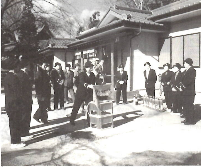
天ぷらなべ火災の消火訓練——元総社地区の婦人防火クラブで
