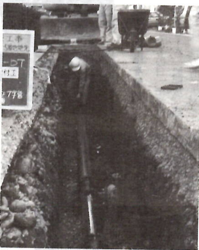
安定給水のため石綿管整備事業も推進
