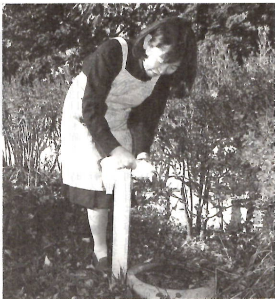
屋外の水道管はタオルなどを巻き付けて保温を
