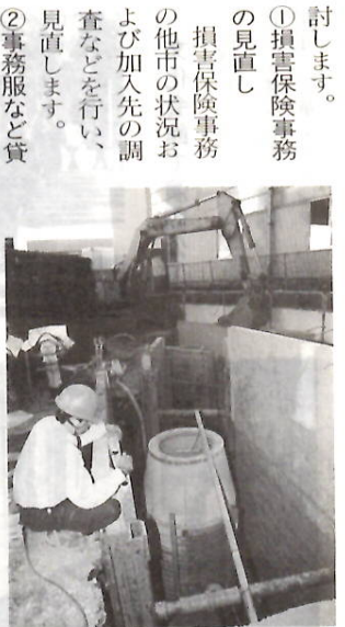
農業集落排水の工事
