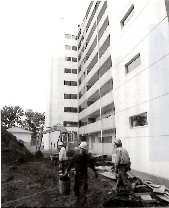
入居に向けて工事が進む広瀬第1団地
