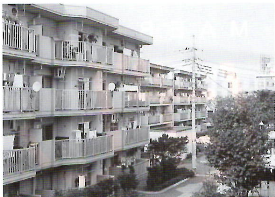
鉄筋コンクリートに建て替えられた団地
