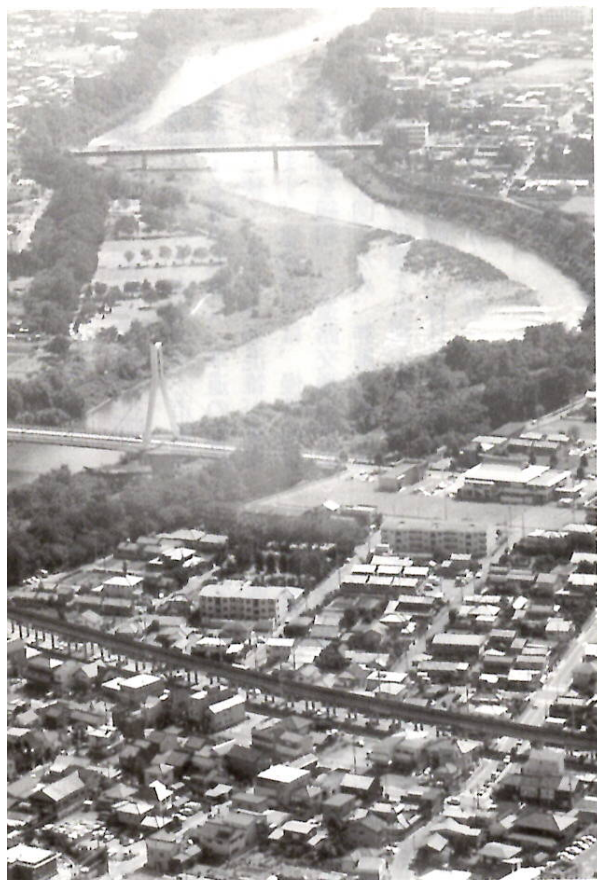
上空からみた平成大橋付近
