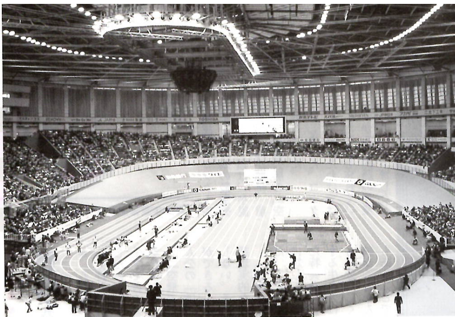
グリーンドーム前橋に設置された室内陸上競技施設
