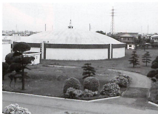
18000立方メートルの配水量がある野中浄水場
