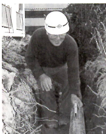
宅地内の排水設備工事
