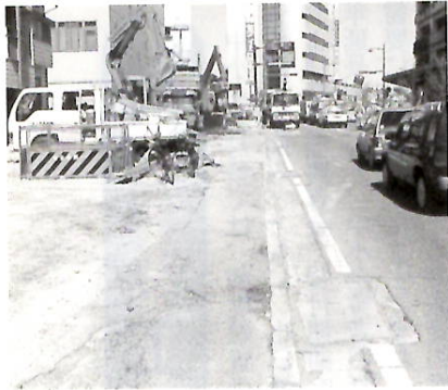
歩道段差解消の工事
