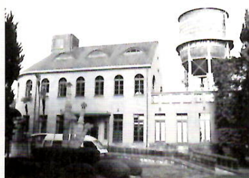
市水道資料館と浄水場配水塔
