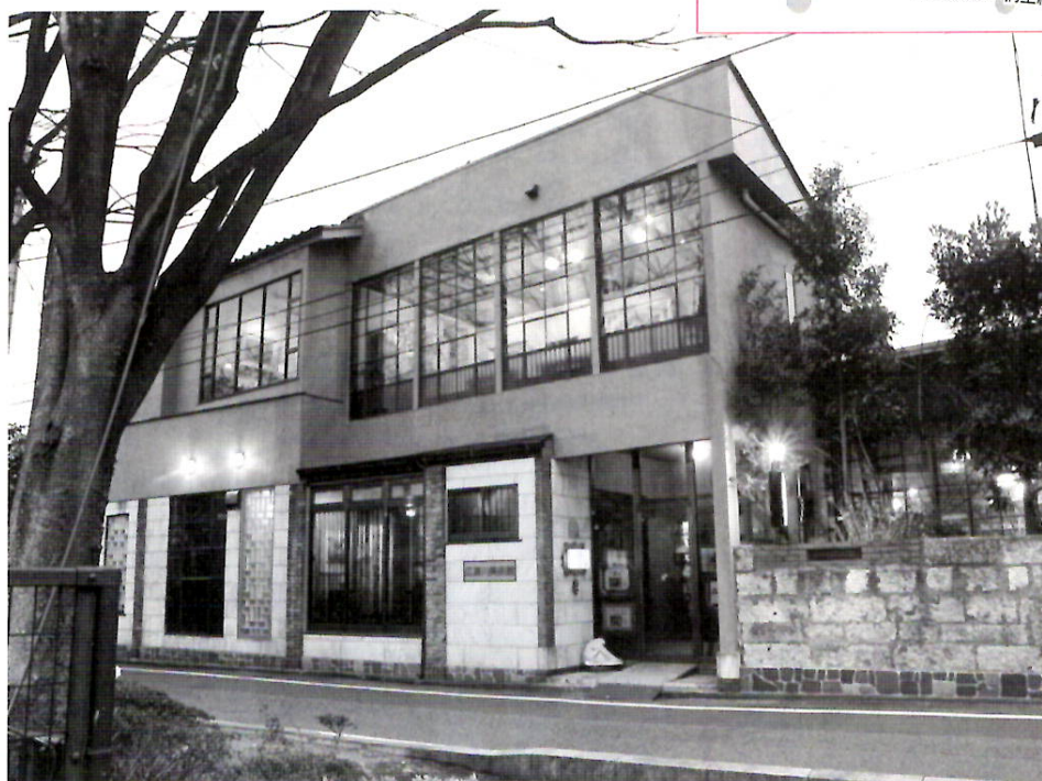
広々とした鉄枠窓の広瀬川美術館
