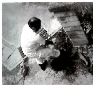
宅地内の漏水を修理
