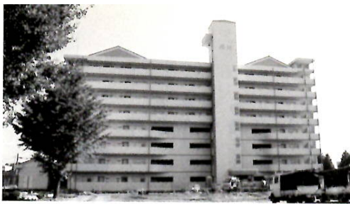
建築中の広瀬第五団地
