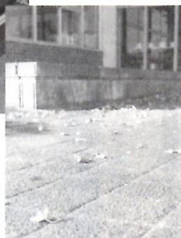
▶溶融スラグを使ったアスファルト平板の舗装
