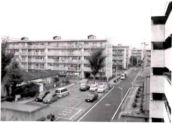
市・県営の住宅が並ぶ南橋町
