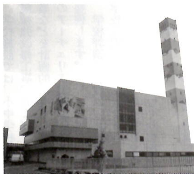
工事を待つ六供清掃工場
