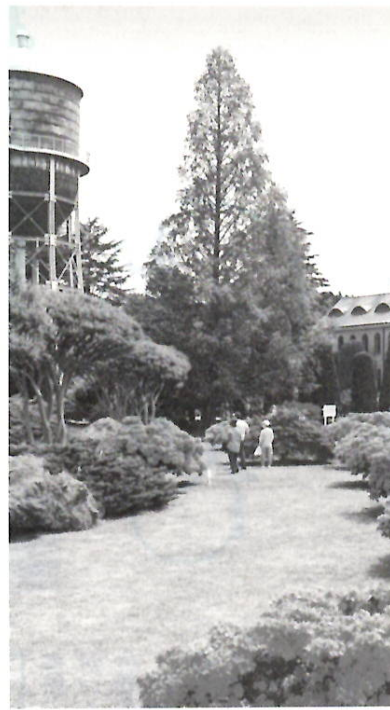
ツツジが咲き競う敷島浄水場
