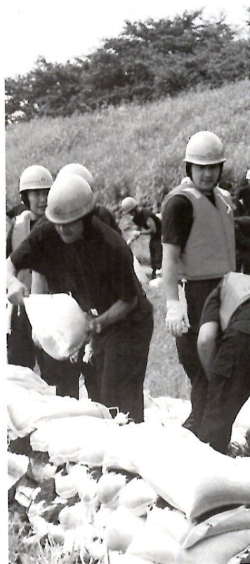
土のうを積んで越水防止
