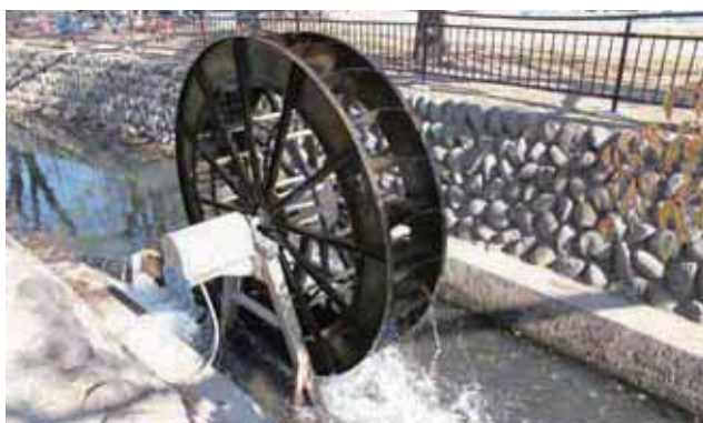
佐久間川に設置した小水力発電装置。昔の水車を思い出す人も多いことでしょう。発電した電気は児童文化センターや前橋子ども公園で利用しています
