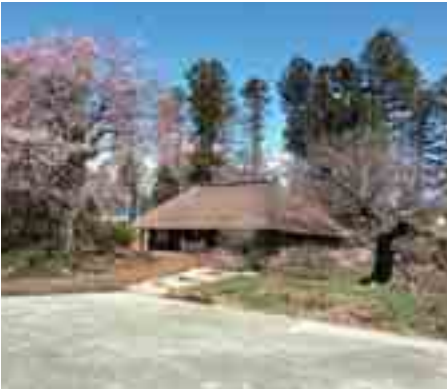
屋根のふき替えを行う阿久沢家住宅
