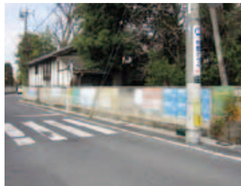
壁一面に貼られた無断広告物
