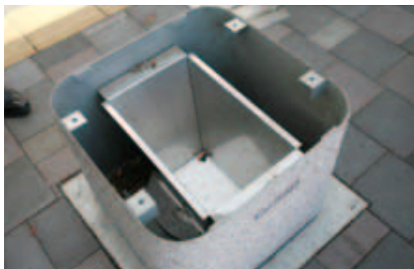
トイレはマンホールに直結
