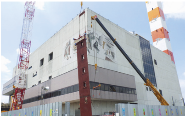
六供清掃工場延命化工事
