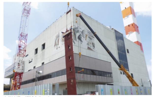
六供清掃工場延命化工事
