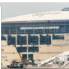
建設中のグリーンドーム前橋
