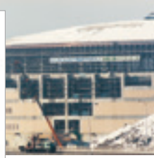
建設中のグリーンドーム前橋
