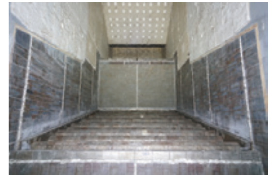
新しい焼却炉内部
