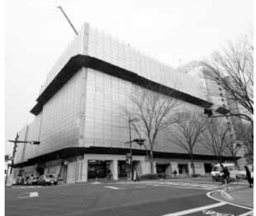
着々と工事が進む旧リヴィン
