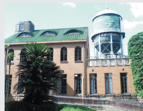
市民とともに歩み続ける敷島浄水場
