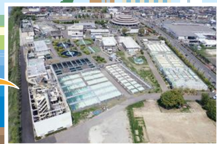
水質浄化センター
