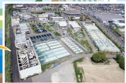
水質浄化センター
