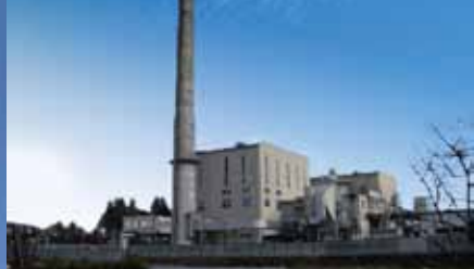
亀泉清掃工場
