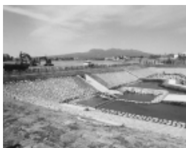
造成工事の進むローズタウン
