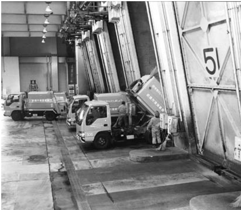
収集車が次々とピットへ（六供清掃工場）
