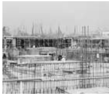
温水利用健康づくり施設の現場
