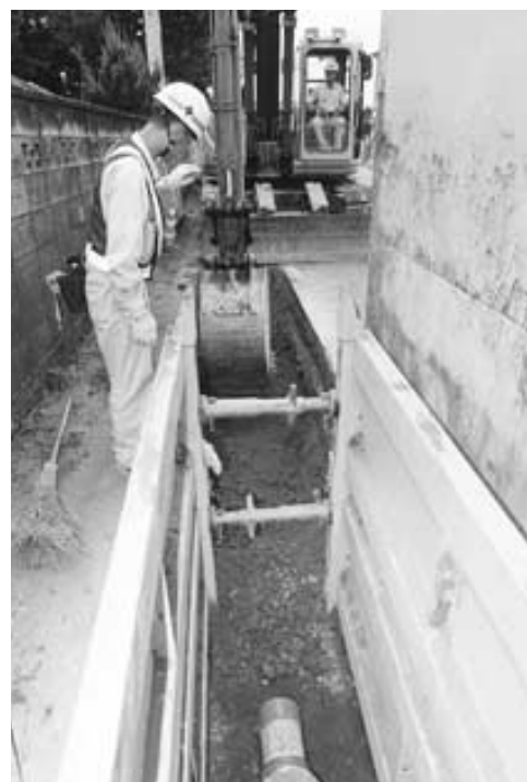
着々と進む下水道管の敷設工事
