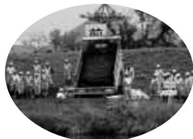
重機を使い水をせき止め
