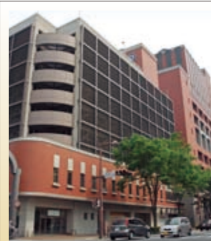
前橋テルサに隣接する施設
