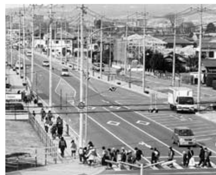
着々と進む道路整備(新前橋駅川曲線)
