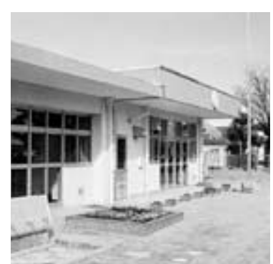
改修したまえばし幼稚園の園舎
