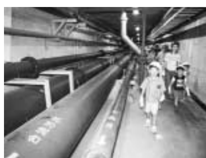
水質浄化センターの地下を探検
